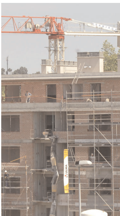
Viviendas en construcción
