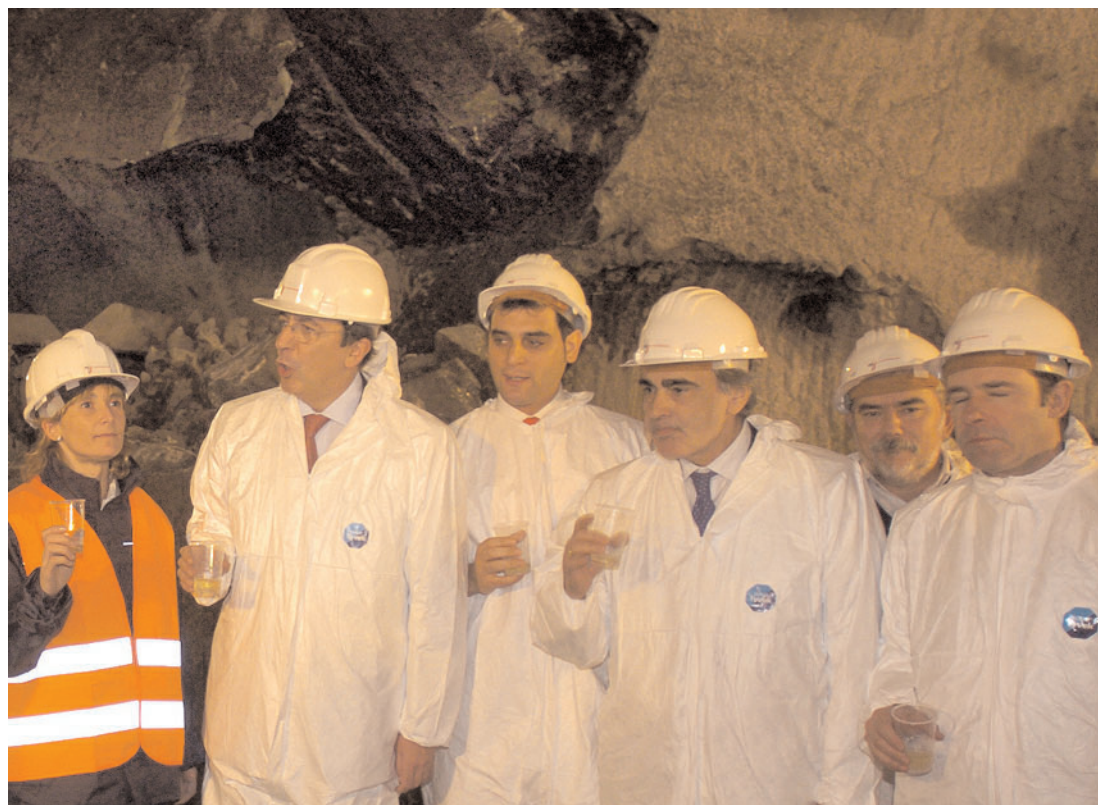
Gerenu, Bilbao e Ituarte brindan en la unión de los túneles del metro que unen Santurtzi y Portugalete
